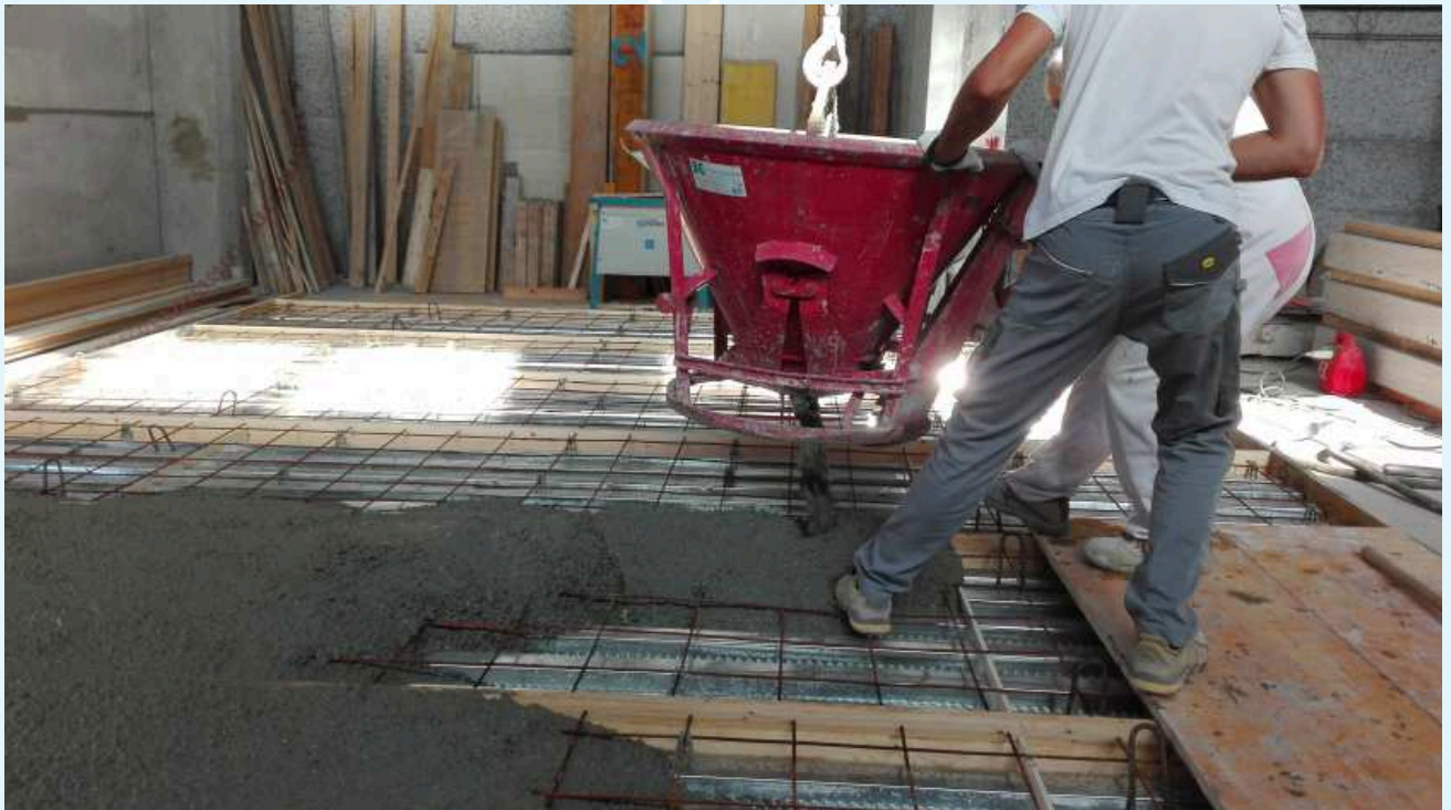
Fotografie del confezionamento dei provini di solaio.
