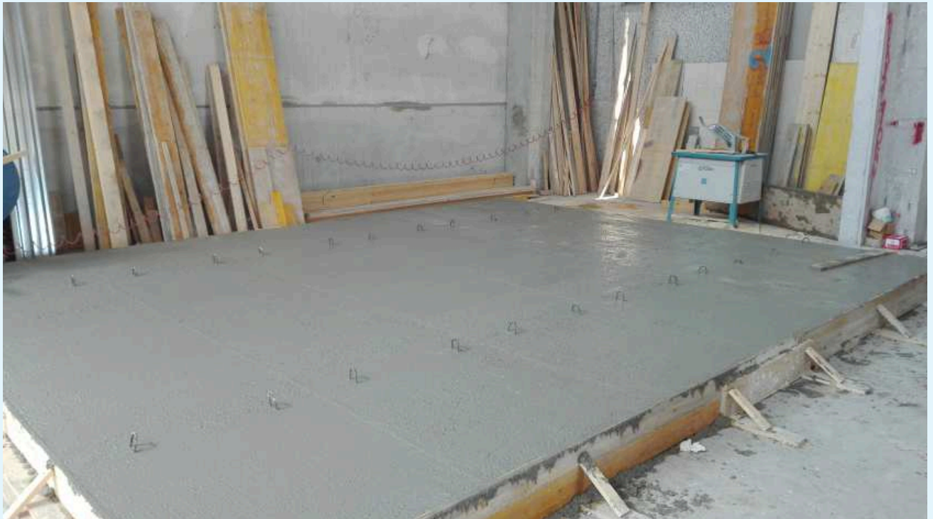
Fotografia del confezionamento dei provini di solaio.
